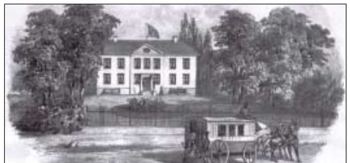
Die Geestkante an der Horner Landstraße war ein beliebter Bauplatz für repräsentative Villen. Dieses Landhaus ließ der Reeder Friedrich Duncker anno 1790 vom Architekten Johann August Arens errichten. Es stand bis zum Juli 1943 im heutigen Horner Park.
